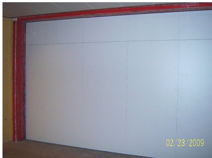
Détail paroi lors du montage
